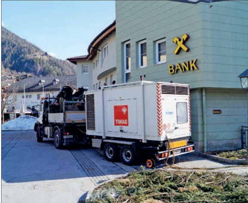
**Von der Tiwag wurden Wartungsarbeiten an der Trafostation am Dorfplatz durchgeführt - ein mobiles Aggregat sorgte dafür, dass währenddessen der Stromfluss erhalten blieb.**
