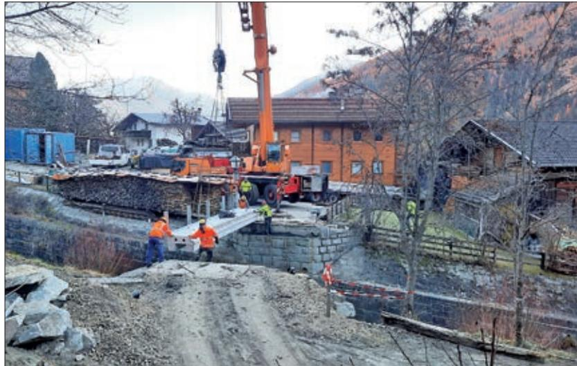
**Einheben der Fertigteilenelemente bei der Tellerbrücke.**
