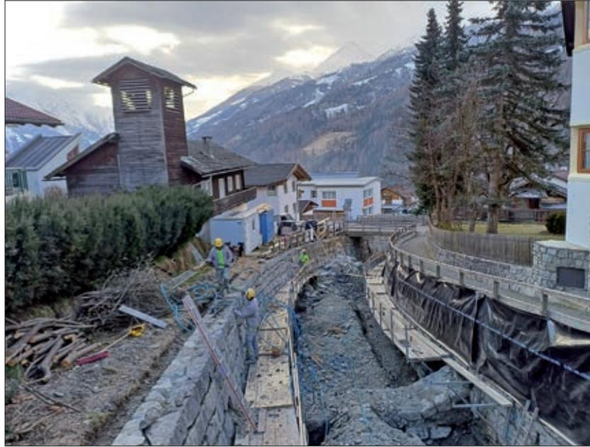
**Die Wildbach- und Lawinerverbauung führt derzeit Sanierungsarbeiten an der Firschnitzbachverbauung durch.**
