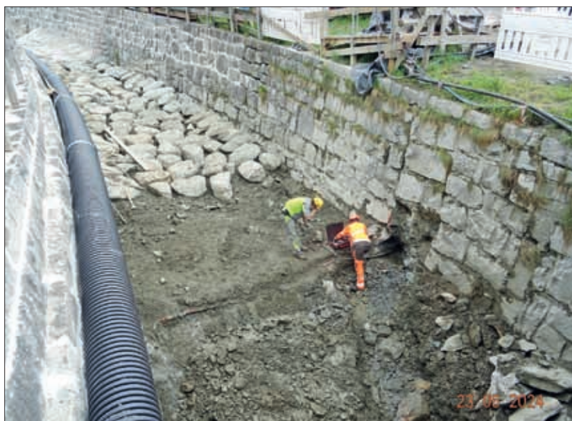
Baumaßnahmen am Firschnitzbach zur Verbesserung des Durchflusses.
