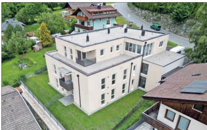
Blick von oben auf die neue Wohnanlage mit 6 Mietkaufwohnungen.
