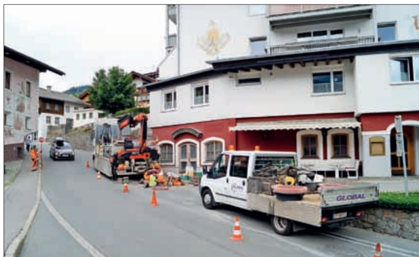
Kanaldeckelsanierungsarbeiten im Ortszentrum.
