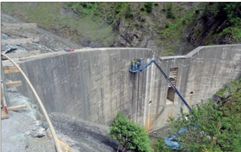
Erhaltungsarbeiten an der „alten“ Firschnitzbachsperre und Errichtung einer Baggerrampe durch die Wildbach- und Lawinerverbauung.
