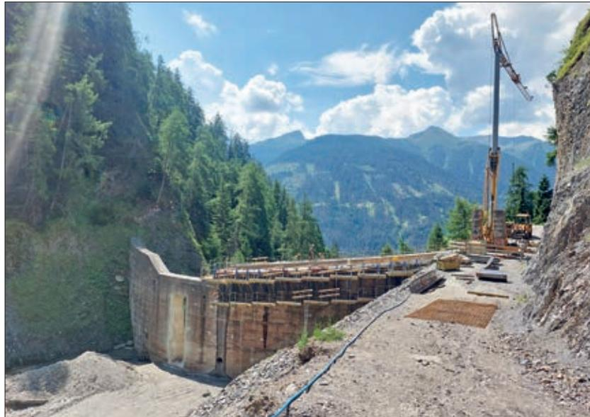
**Die WLV-Osttirol hat Sanierungsmaßnahmen an der oberen Sperre des Firschnitzbaches durchgeführt. Neben Arbeiten am Mauerwerk der Sperre wurde auch eine Zufahrtsrampe in das Rückhaltebecken errichtet, welche das Räumen von Geschiebe mit schwereren Fahrzeugen erleichtern soll.**
