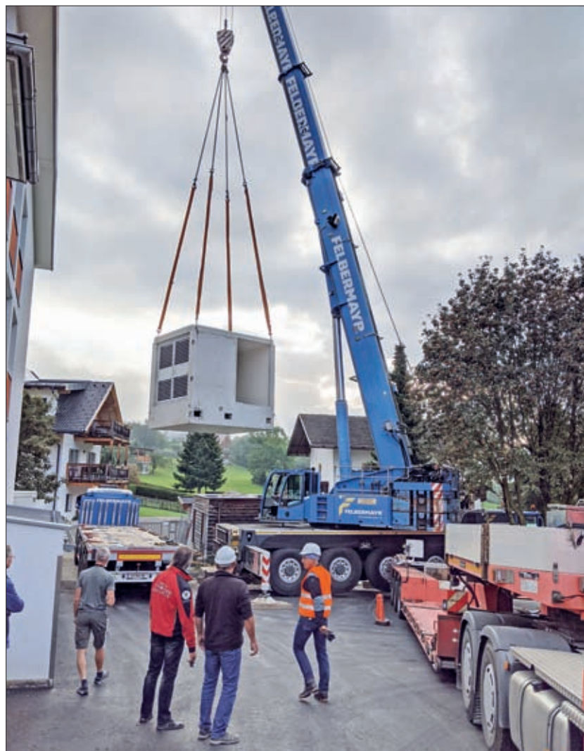
Zur Versorgungssicherheit errichtet die TINETZ eine ferngesteuerte Ortsnetzstation in Virgen.
