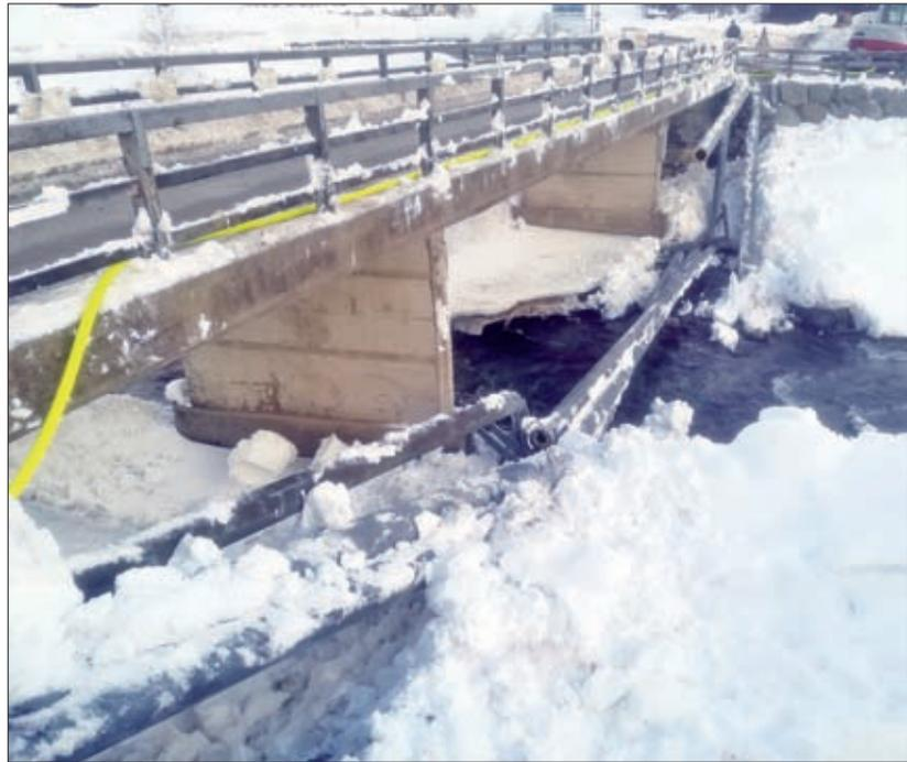
**Bruch der Gemeindehauptwasserleitung und des Sammelkanals bei der Grieser Brücke. Durch sofortiges Handeln konnte der Schaden schnell - vorläufig provisorisch - behoben werden.**
