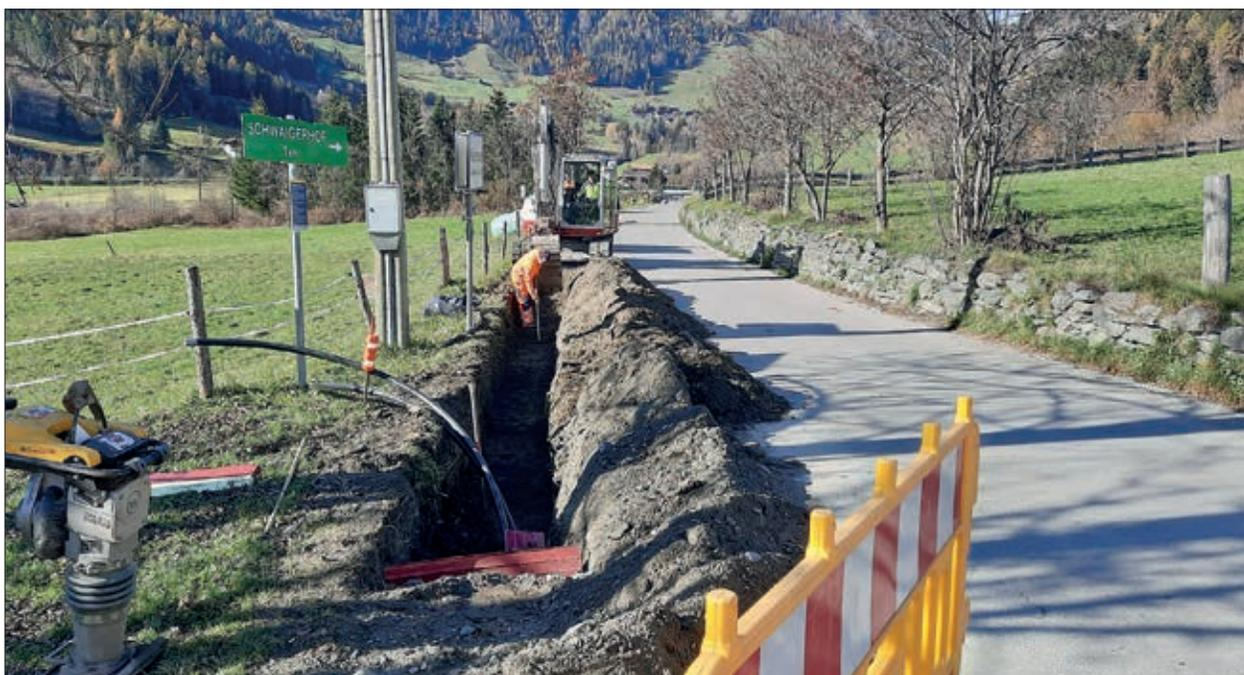
**Grabungsarbeiten an der Gemeindestraße in Niedermauern durch die TINETZ (Netzverstärkung) - in diesem Zuge wurden auch LWL-Kabel mitverlegt.**
