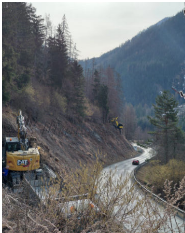
Die Wildbach- und Lawinenverbauung führt oberhalb der Landesstraße in „Unterpöllach“ Hangsicherungsmaßnahmen durch.
