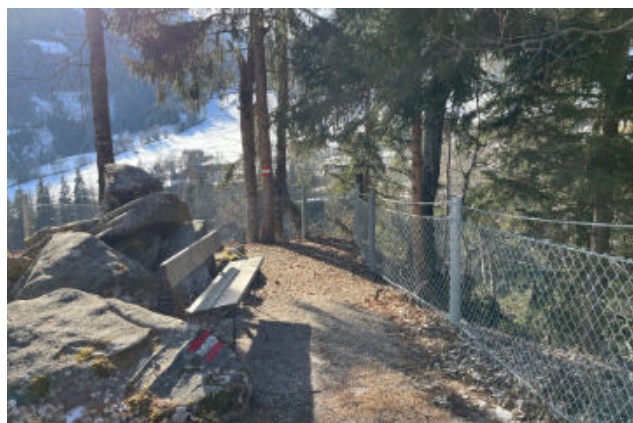
Bestehender Rastplatz, hier wird die Aussichtsplattform angebaut (Foto Walter Hopfgartner).
