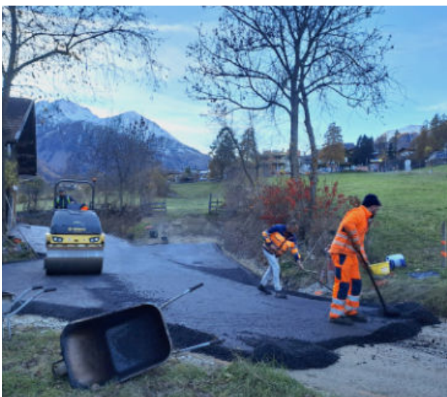
Asphaltierungsarbeiten Hofzufahrt Klamperer.
