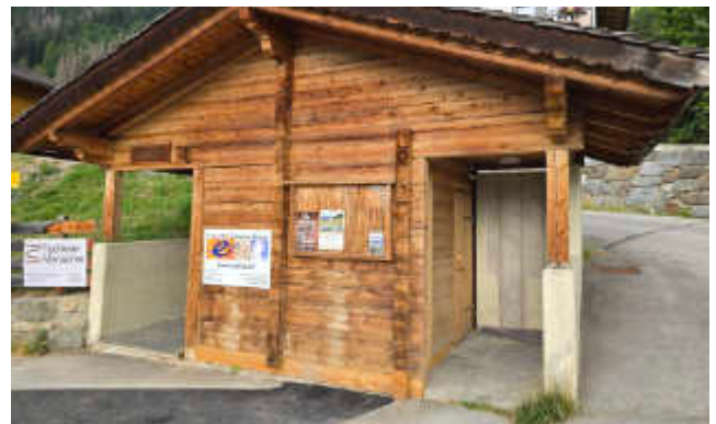
Im Info-Hüttl in Welzelach wird eine WC-Anlage errichtet. (Foto: Bernhard Aßmair)
