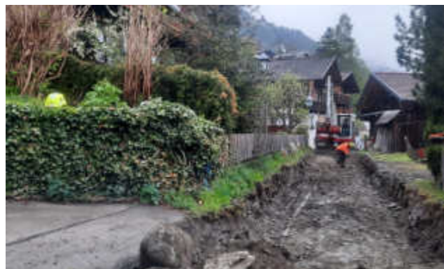
Im Herbst sind die Grabungsarbeiten für das Glasfasernetz abgeschlossen.
