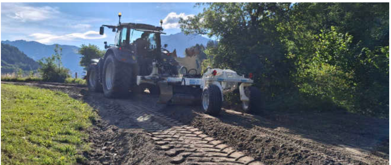
Straßensanierung Richtung Tratte Mitteldorf: Der bestehende Asphalt wurde gefräst, die Fahrbahn anschließend gegrädert, bombiert und abschließend gewalzt.
