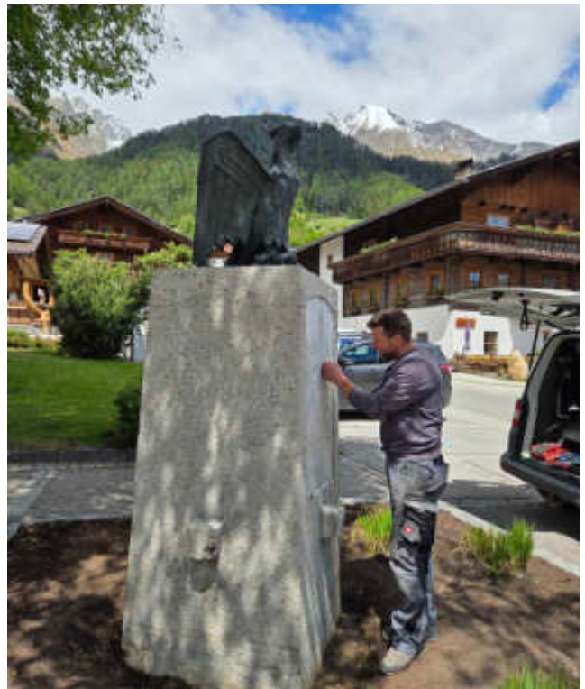
Lukas Fuetsch führte im Auftrag der Gemeinde Renovierungsarbeiten am Kriegerdenkmal durch.
