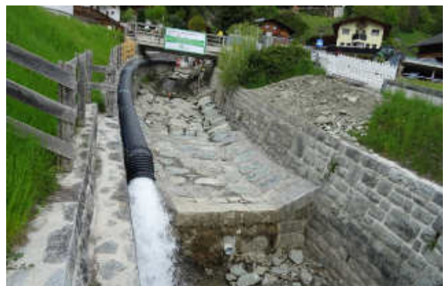
Durch eine Veränderung der Bachsohle im Ortsregulierungsbereich bei den Brücken wird ein schadloser Abtransport von Murmaterial unterstützt.
