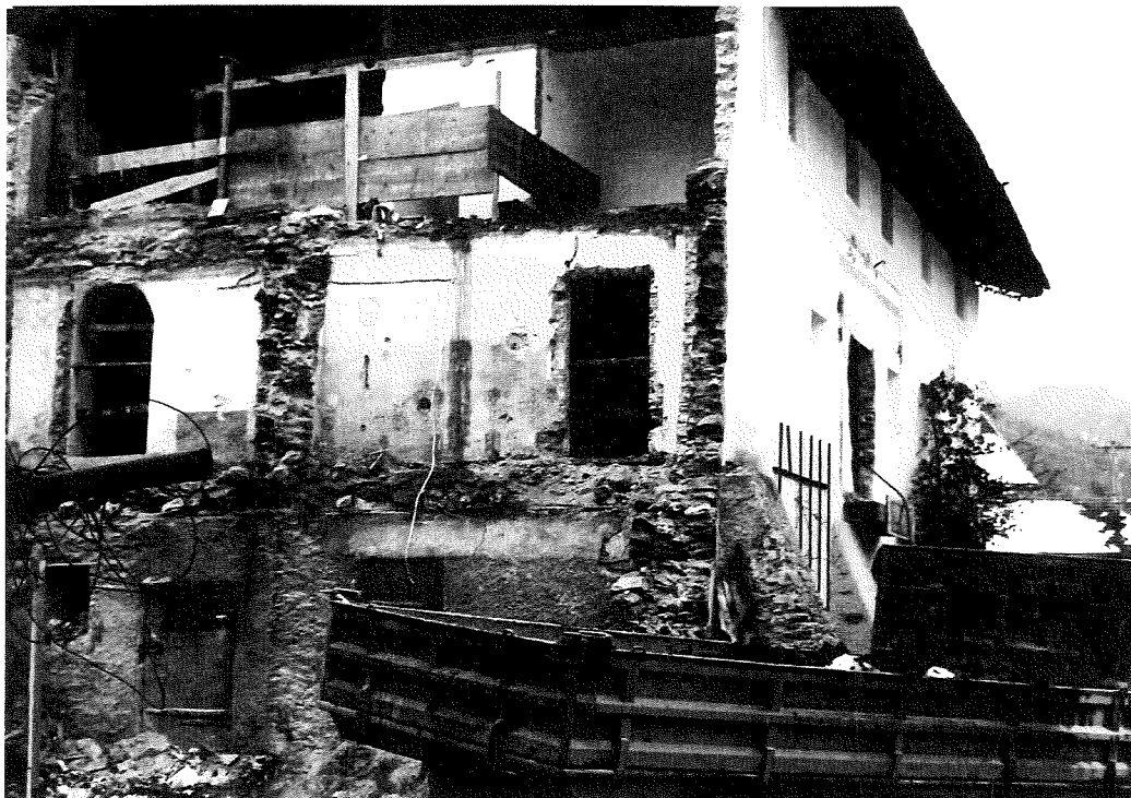
Der Umbau im April 1979 : Abbruch des „Kooperatorenrakts“
