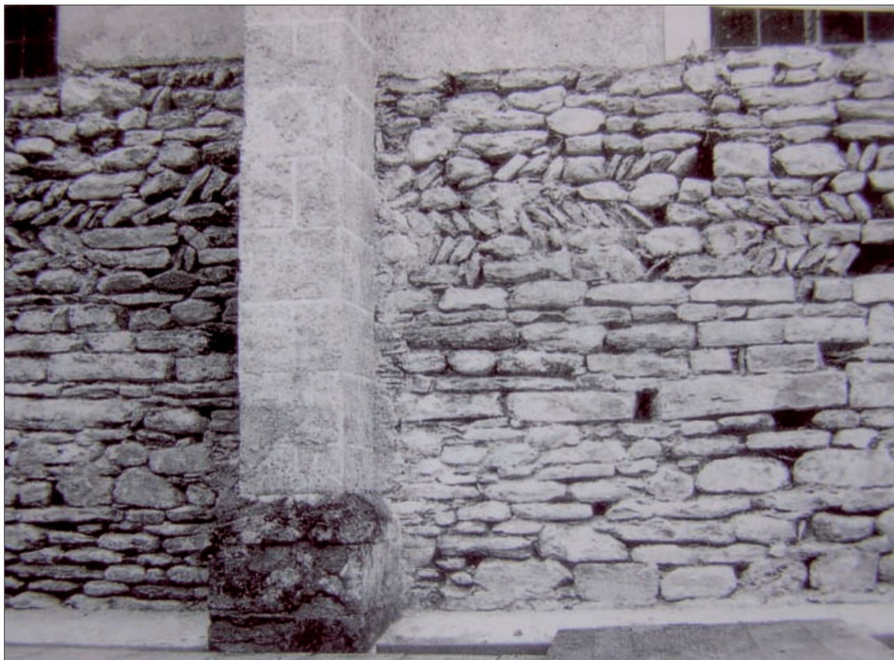
Abb. 6: Ein Indiz, dass unsere Pfarrkirche schon sehr alt ist, sind die ährenförmig oder fischgrätenartig angeordneten Steine in der Nordwand. Diese Art zu mauern stammt von den antiken Römern und wurde bis ins Mittelalter praktiziert (Fachausdruck: opus spicatum)
