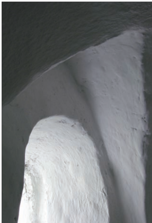
Abb. 7: „Stichkappen“ nennt man die spitz zulaufenden Zwickel im Gewölbe, hier, in der Kapelle auf dem Sonnberg, wird eine durch das Fenster schön beleuchtet.
