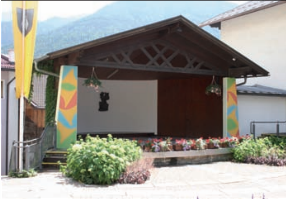
Malerarbeiten am Pavillon.
