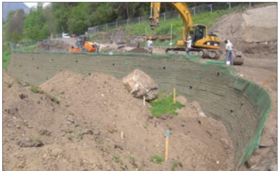
Herstellen der Zufahrt mittels „bewehrter Erde“
