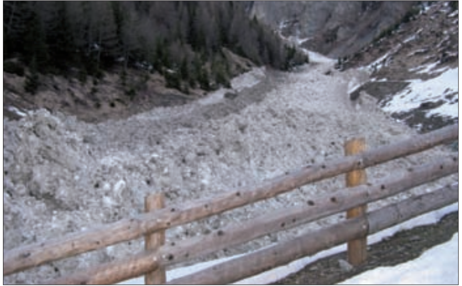
Die neue Lawinerverbauung brachte die Lawine im Mellitzgraben zum Stillstand.
