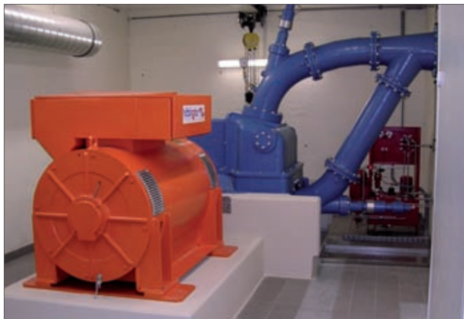
Beim Kraftwerk Steinkasbach wurde eine limnologische Beweissicherungsuntersuchung durchgeführt.
