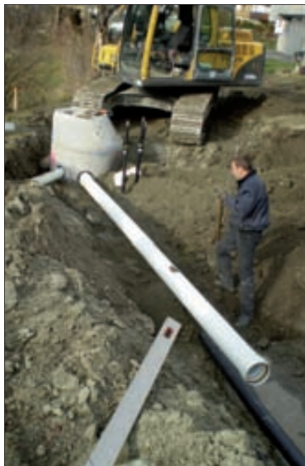
Kanalverlegung in Haslach.
