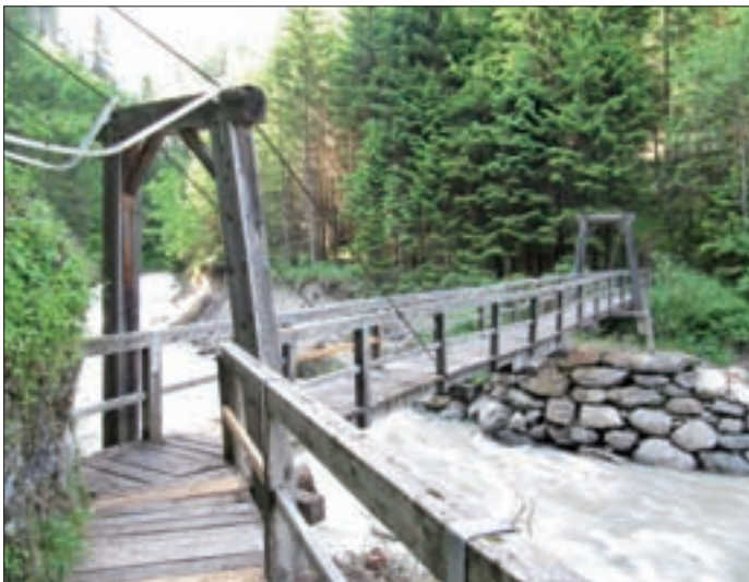
Mithilfe von Eisen- und Holzhalterungen sowie Erdaufschüttung konnte der Iselsteg wieder zugänglich gemacht werden.
