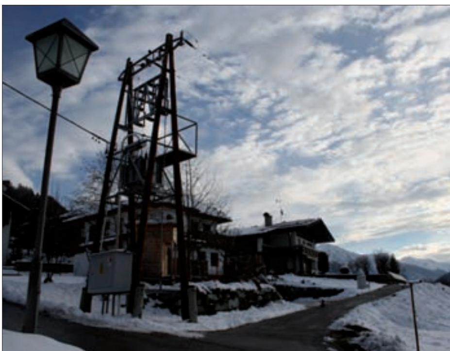
Die 25 kV-Hochleitung in Haslach wird im kommenden Jahr verkabelt.
