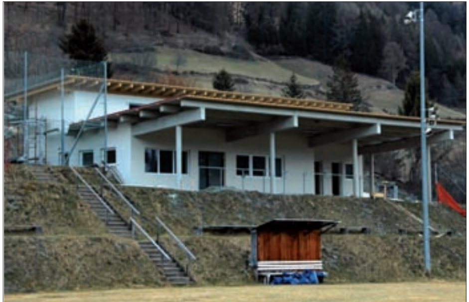
Der Kabinenneubau beim Sportplatz schreitet zügig voran.
