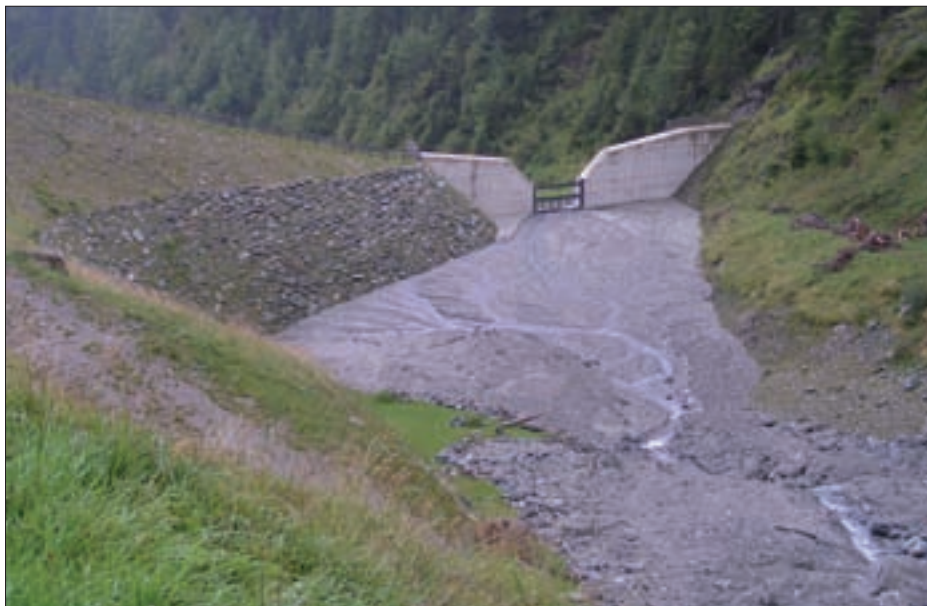
Das Murmaterial im Rückhaltebecken Mellitzbach musste noch vor Wintereinbruch weggeräumt werden
