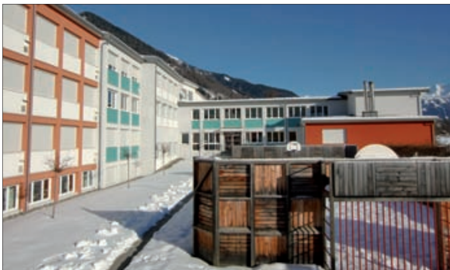
Für das Virger Schulgebäude wurde ein Energieausweis berechnet.
