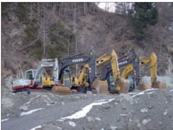
Die Firma verfügt über Hydraulikbagger von 1,5 bis 24 t.
