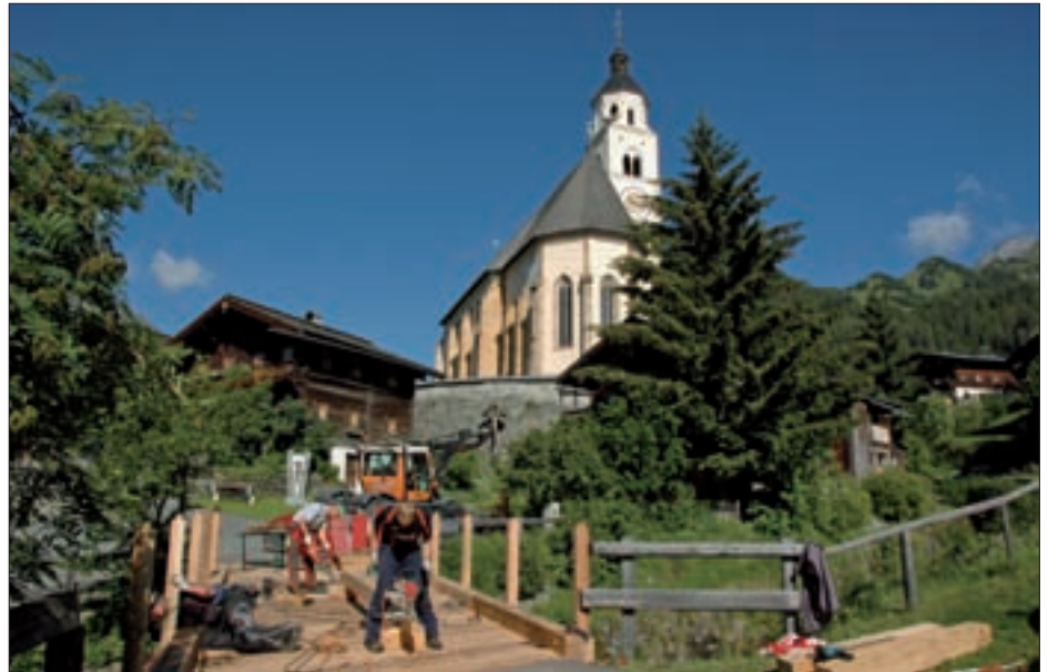
Brückensanierung in Obermauern bei vlg. Rösser.
