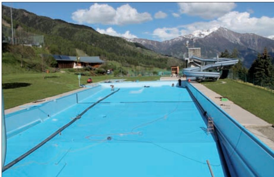
**Das Schwimmbecken wurde mit einer Folie ausgekleidet und ist nun wieder „dicht“.**
