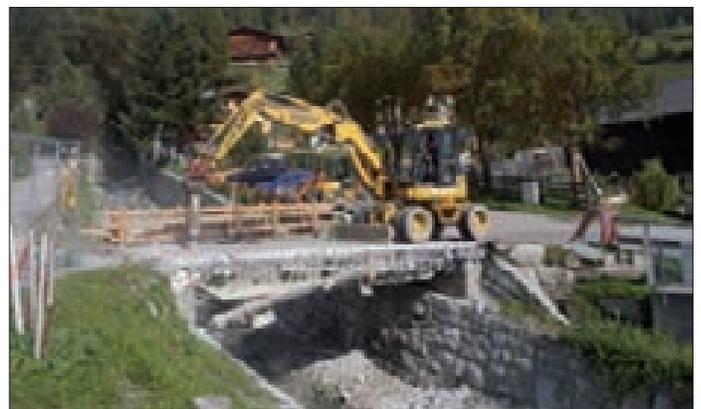
*Abriss der stark beschädigten Brücke in Göriach.*
