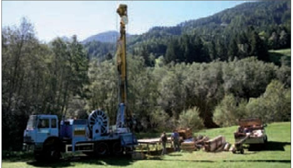
**Die Arbeiten für die Einreichunterlagen zur „Wasserkraft Obere Isel“ sind im vollen Gange. Neben den archäologischen Erkundungen werden auch Untersuchungen des Erdbodenaufbaues an zuvor festgelegten Stellen durchgeführt, u. a. auch in Mitteldorf mittels Probebohrungen.**
