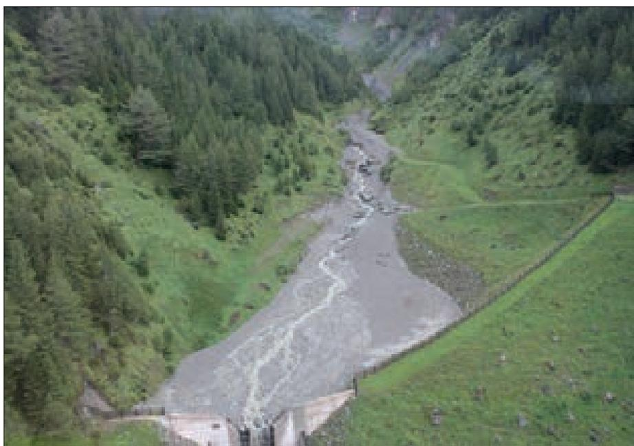
Die Sperre im Mellitzgraben war ebenso bis oben hin voll. Im Unterlauf des Mellitzbaches entstand Sachschaden an der Kneipp-Station.
