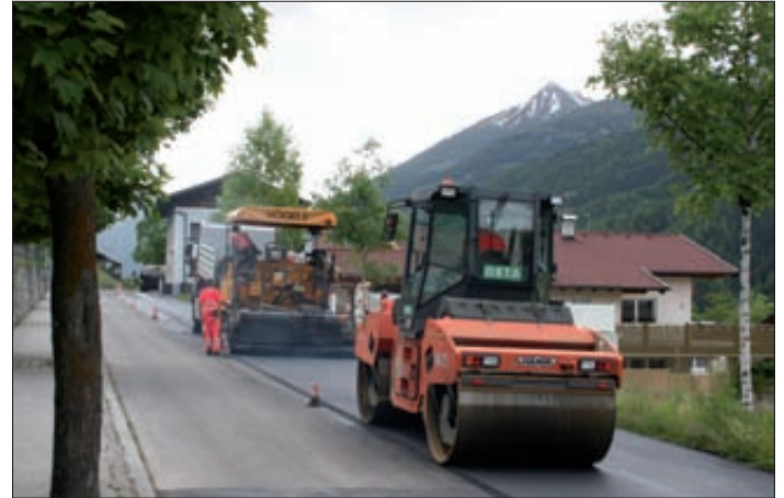
Asphaltierungsarbeiten an der Landesstraße.
