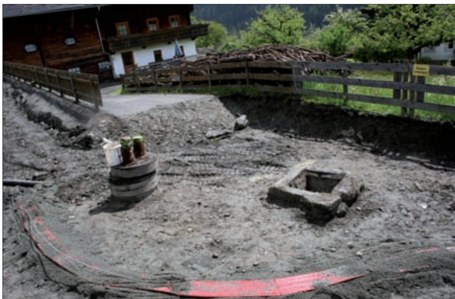
Beim Dorfweg wurden alte Wasserleitungen, Kanalrohre, Schächte und Erdkabel neu verlegt.
