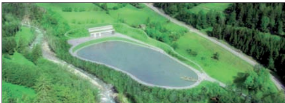
Krafthaus mit Schwallausgleichsbecken.
