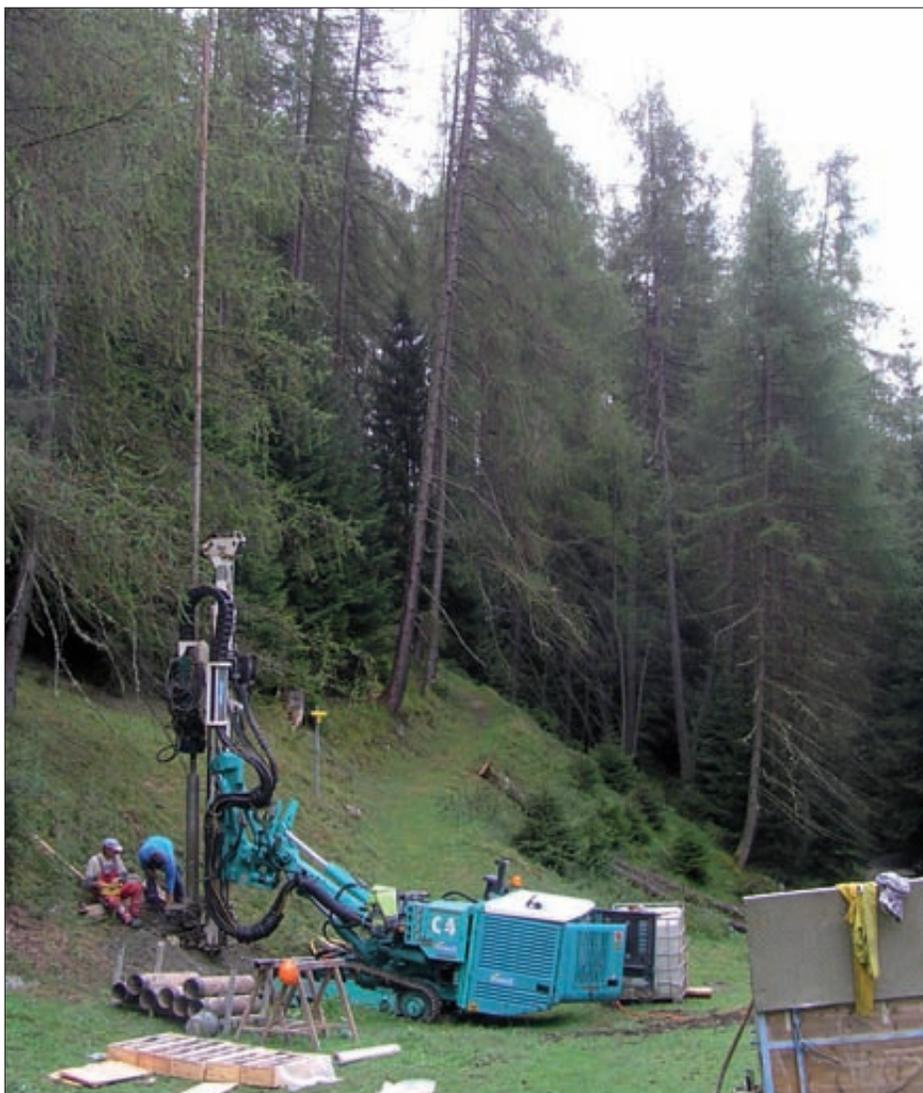
**Bodenerkundung am Firschnitzbach für die Errichtung der Geschieberückhaltesperre.**
