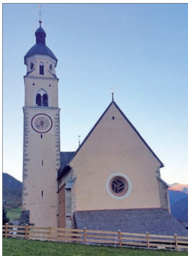
An der Wallfahrtskirche in Obermauern wurden dringend notwendige Sanierungsarbeiten getätigt.
