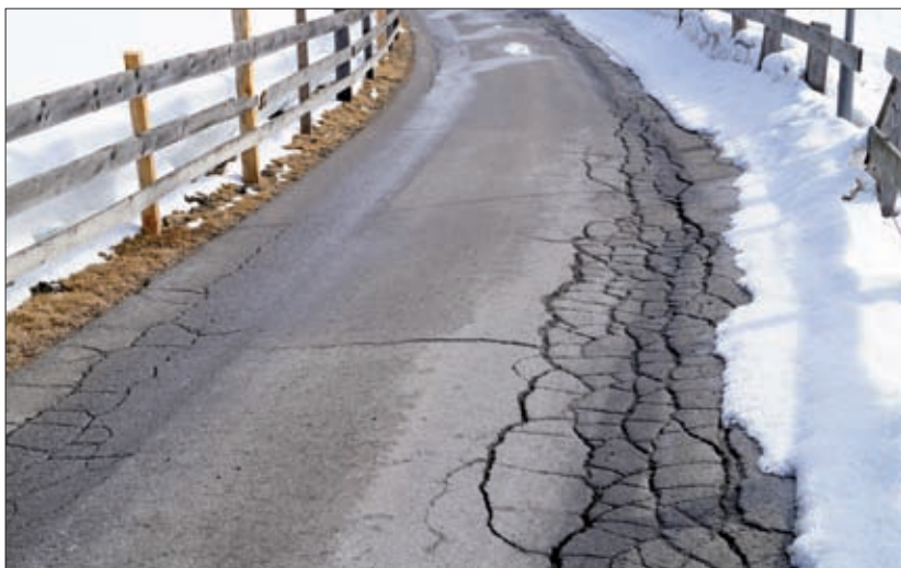
Bei der Gemeinderatssitzung am 23. Februar wurde beschlossen, welche Gemeindestraßenabschnitte heuer saniert werden.
