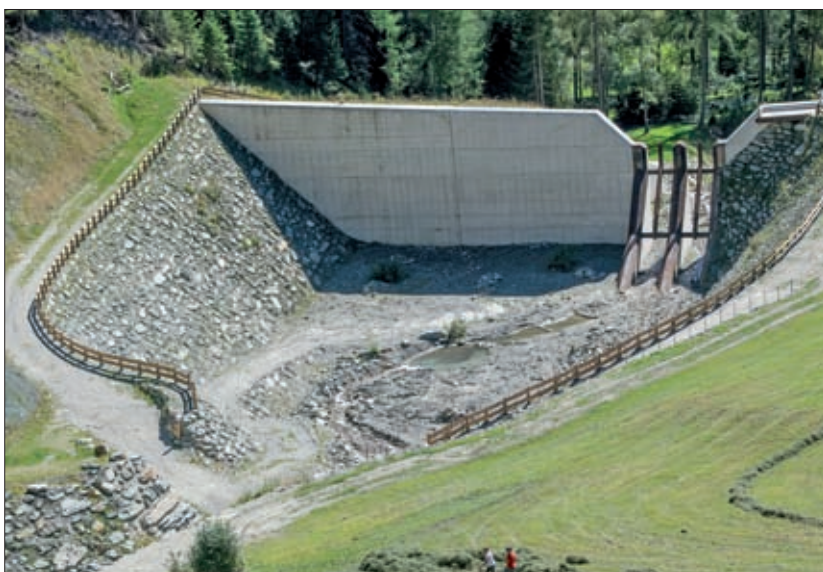
Mit der Fertigstellung der Schutzbauwerke sind die kostenintensivsten Maßnahmen am Firschnitzbach abgeschlossen.
