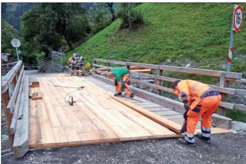
Die Gemeindearbeiter beim Sanieren der Brücke in Mitteldorf unter vlg. Stöffler.
