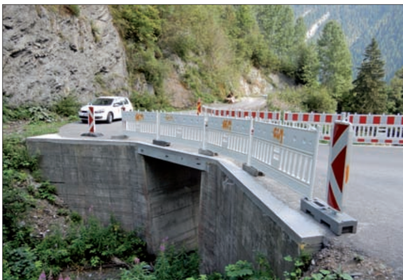
Sanierung der Brücke übers Berger Bachl durch Arbeiter der Agrar Lienz.
