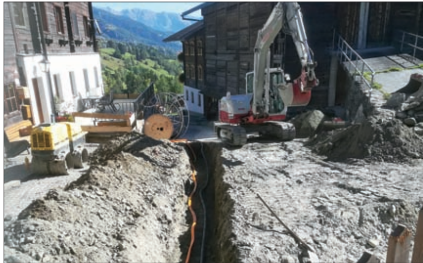
Im Zuge der Straßensanierungen wurden wieder LWL-Schutzrohre für die Breitbandversorgung mitverlegt.
