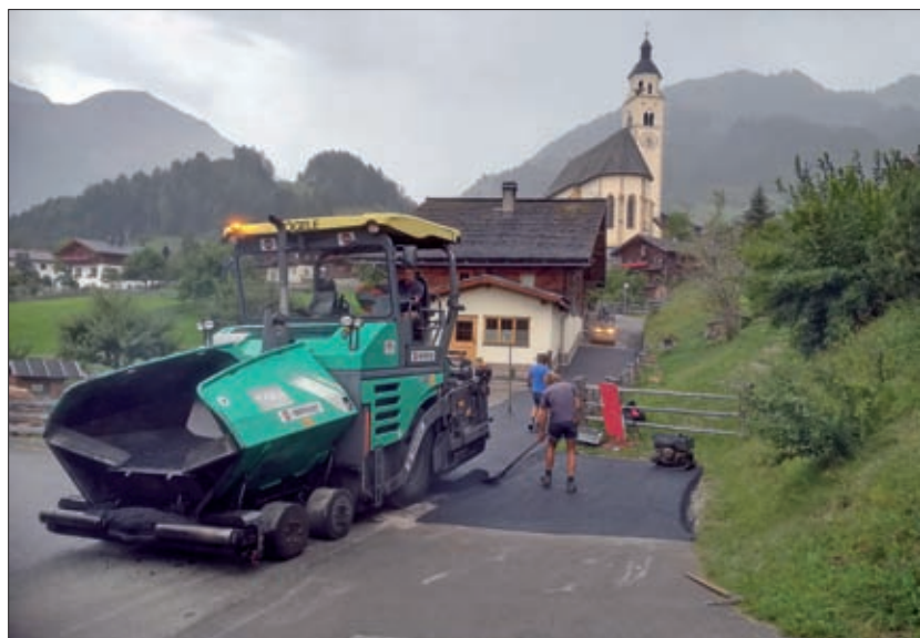
In Obermauern hinter vlg. „Rösser“ wurde die Gemeindestraße saniert.
