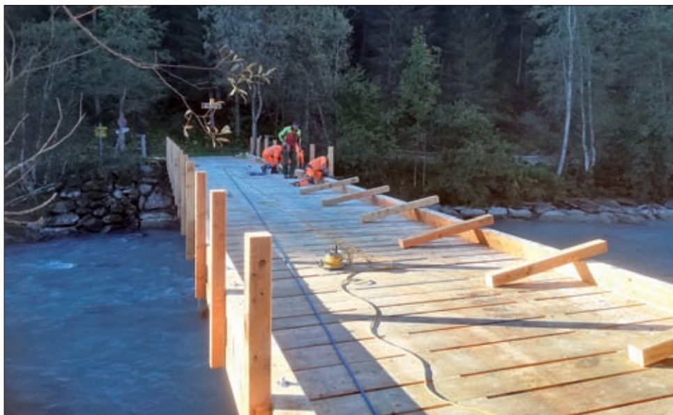
Die Säge-Brücke über die Isel wurde erneuert.
