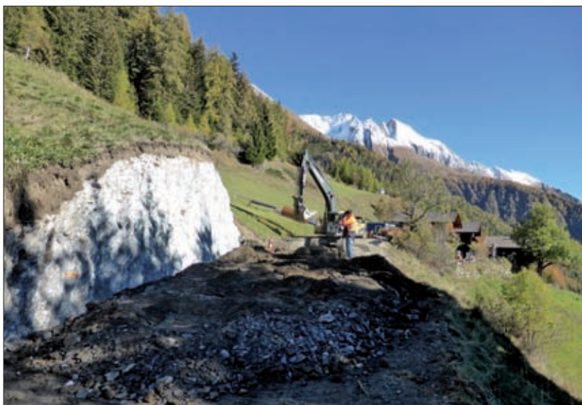
Arbeiten an der Gemeindestraße Richtung Budam.
