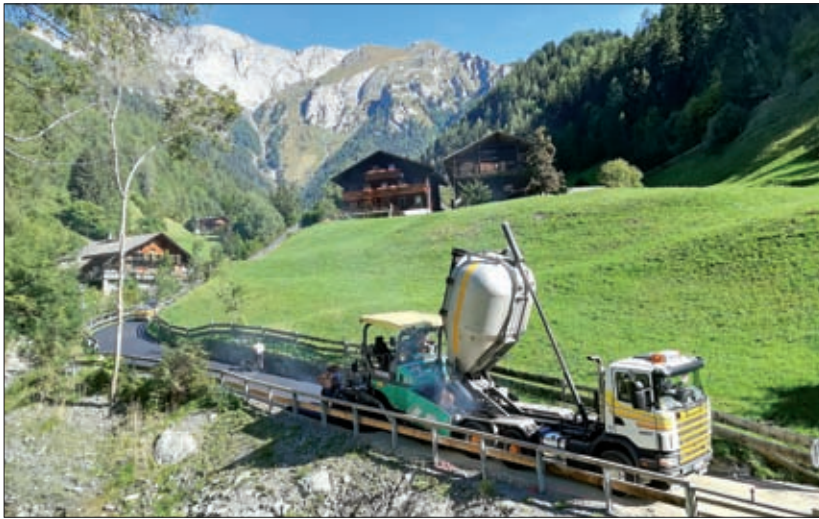
Asphaltierungsarbeiten in Mitteldorf.
